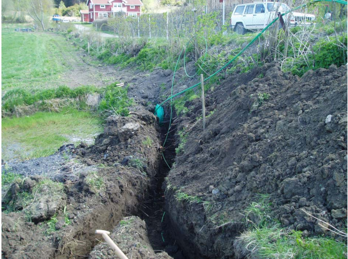
Bild 56. Från skarv 1 tub till 4 tub utanför 4:6 mot fastighet 4:6 och bort mot 4:7
