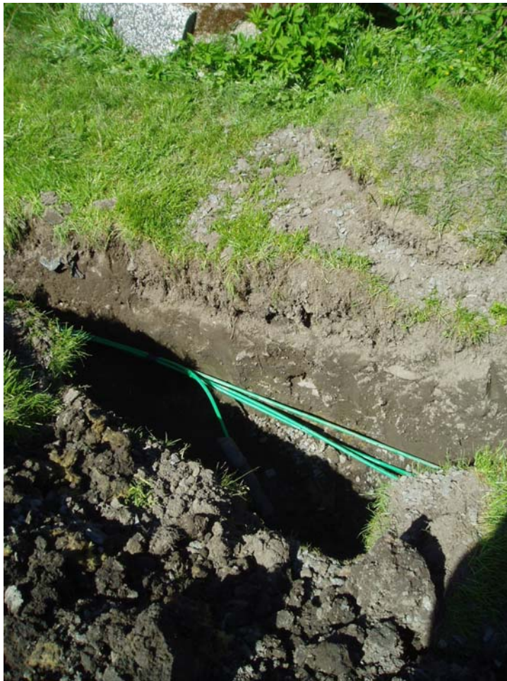
Bild 77. Schakt över 4:7 mot 4:7 b
