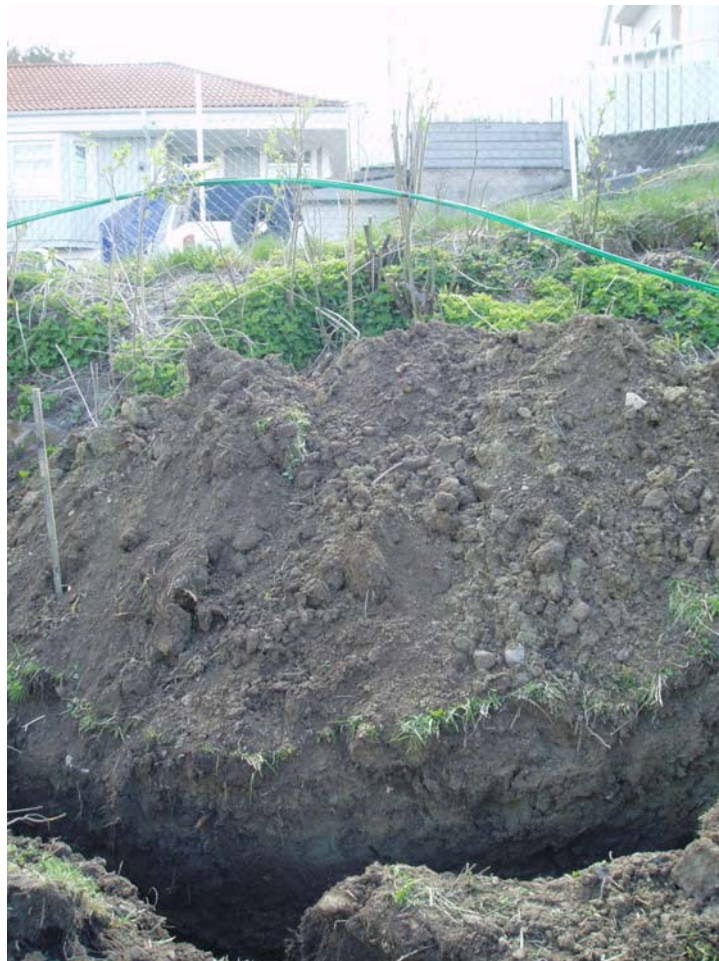
Bild 57. Från skarv 1 tub till 4 tub utanför 4:6 mot fastighet 4:6 och bort mot 4:7
