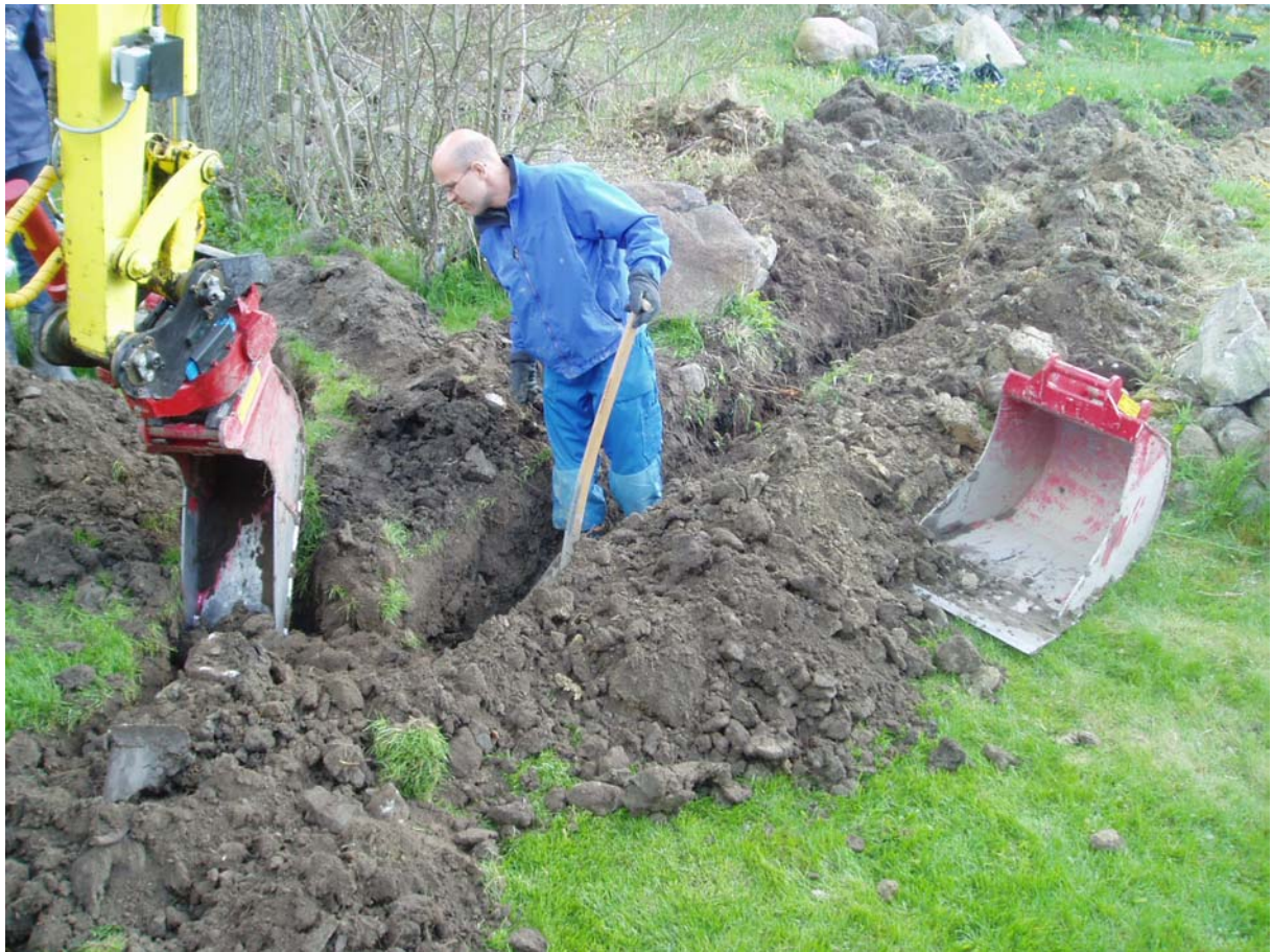
Bild 68. Schakt mot 4:7 a
