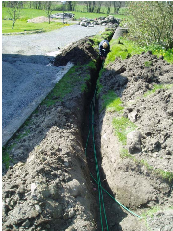
Bild 72. Schakt över 4:7 och mot 5:8
