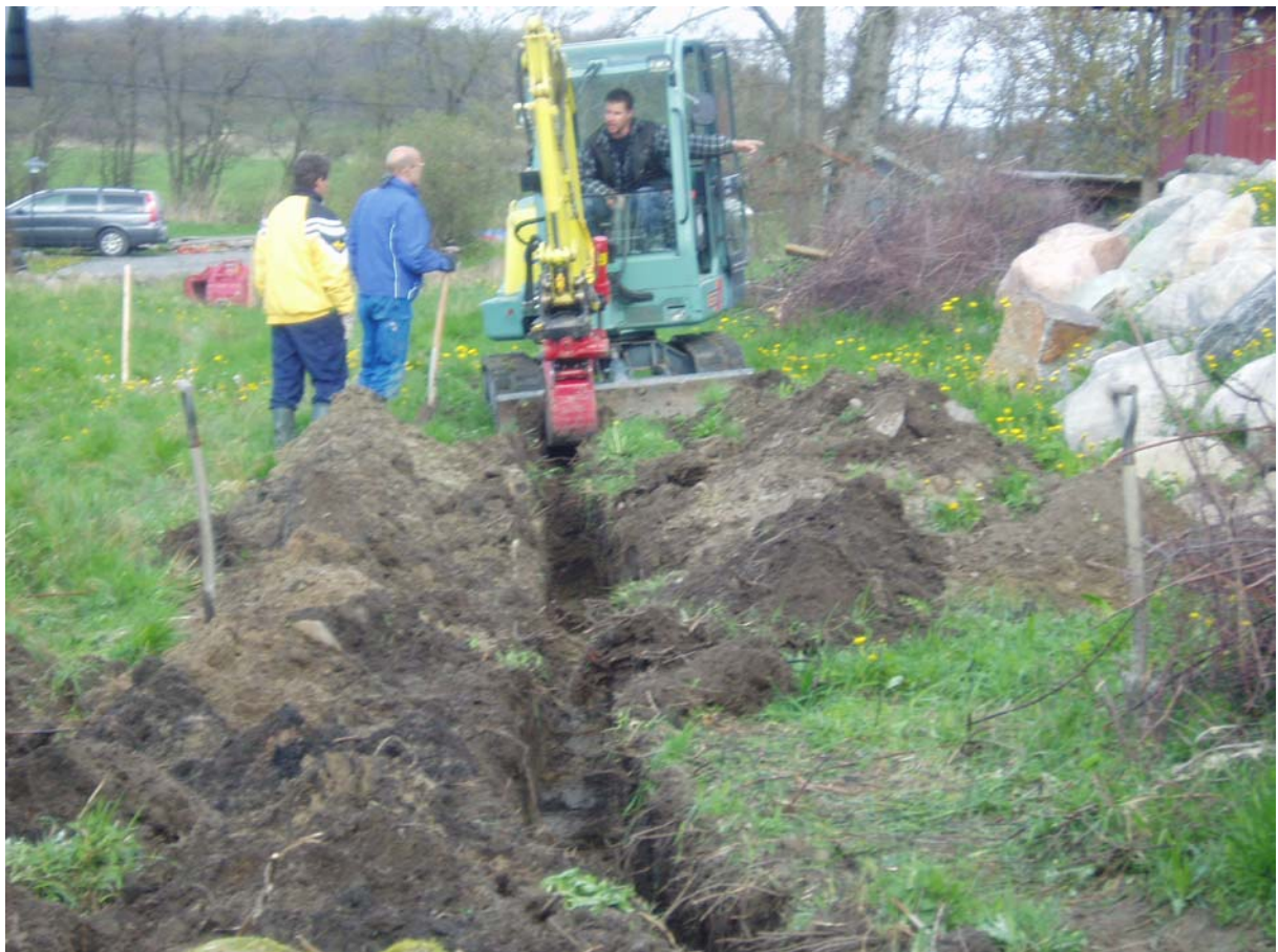
Bild 65. Schakt från 4:7 mot 5:8
