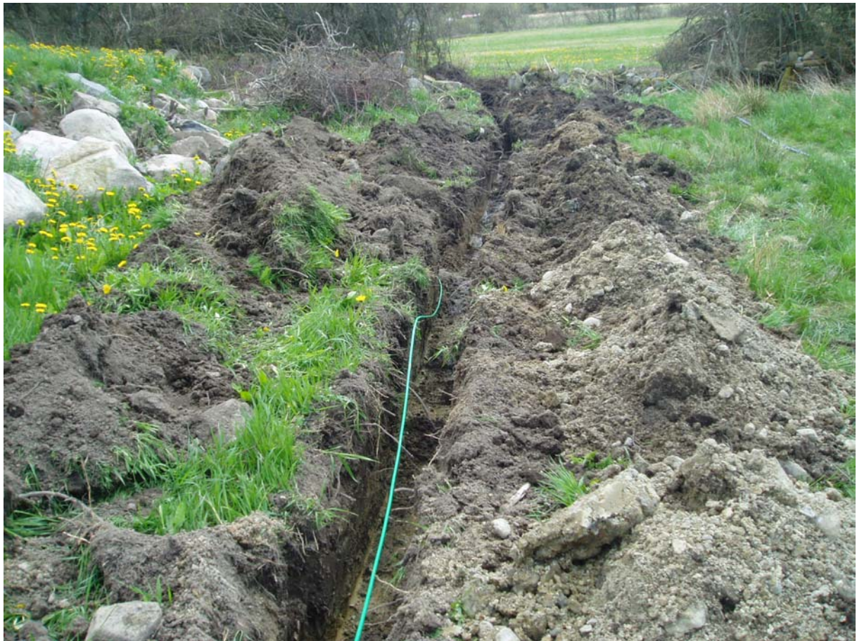
Bild 64. Schakt från 4:7 mot 5:8
