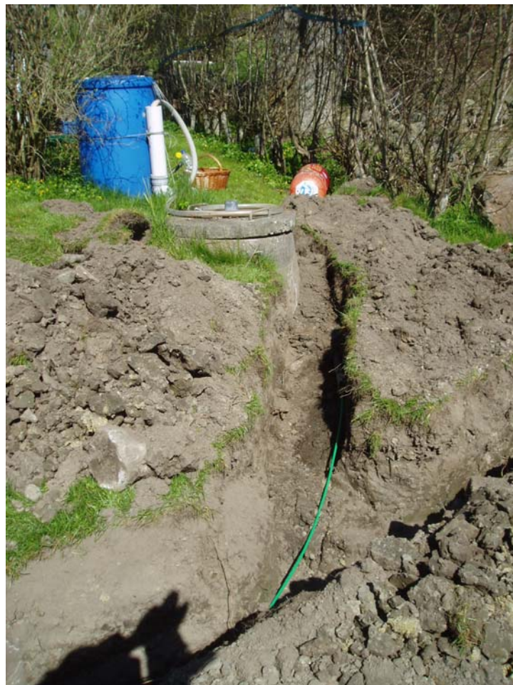
Bild 70. Schakt mot 4:7 a och mot 5:8
