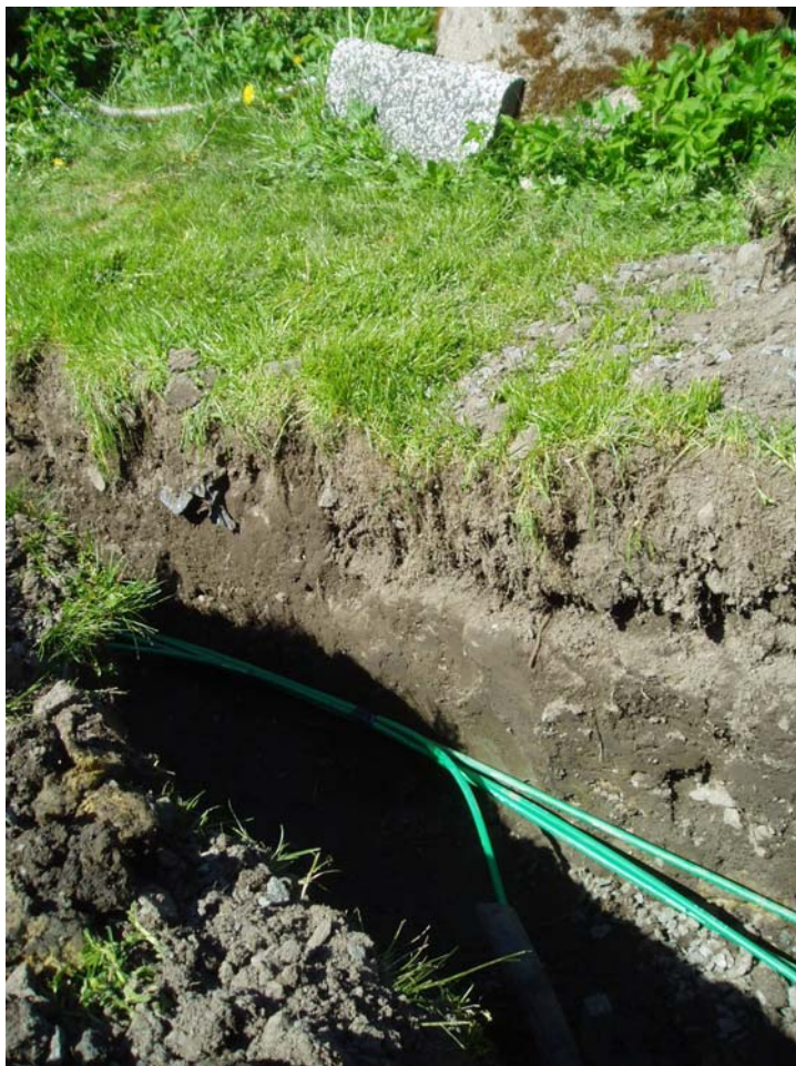
Bild 80. Schakt över 4:7 mot 4:7 b
