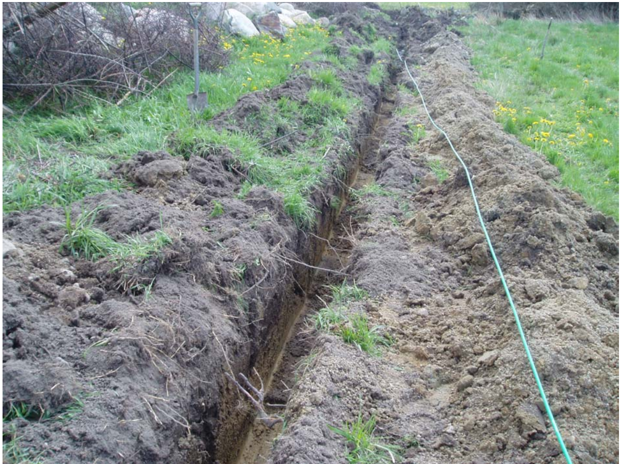
Bild 66. Schakt från 4:7 mot 5:8
