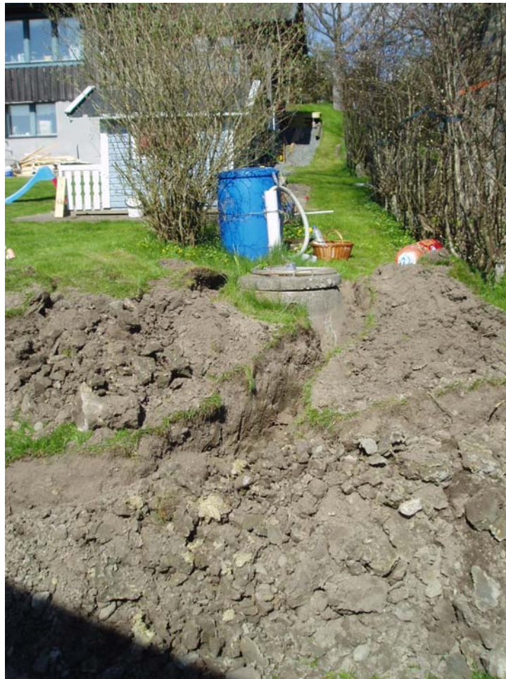
Bild 71. Schakt mot 4:7a och mot 5:8
