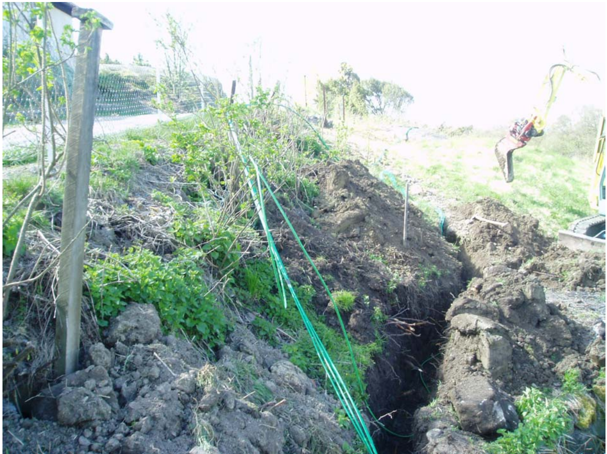
Bild 58. Från skarv 1 tub till 4 tub utanför 4:6 mot fastighet 4:6
