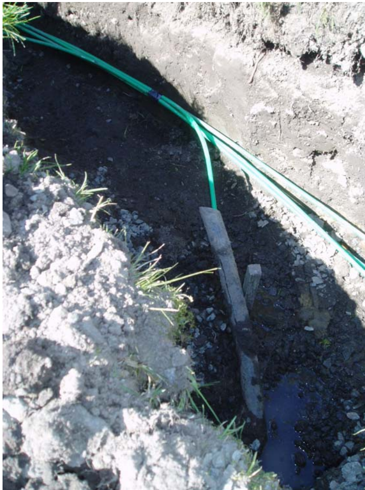
Bild 79. Schakt över 4:7 mot 4:7 b. Förläggs i äldre vattenslang.
