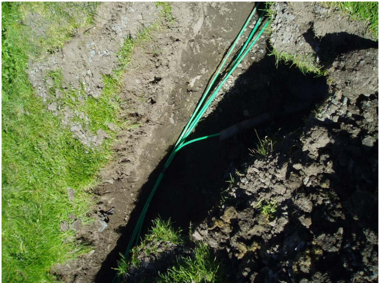
Bild 78. Schakt över 4:7 mot 4:7 b
