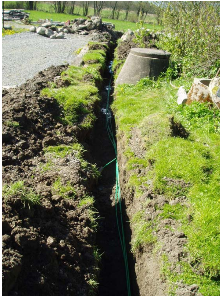
Bild 75. Schakt över 4:7 och mot 4:7 b
