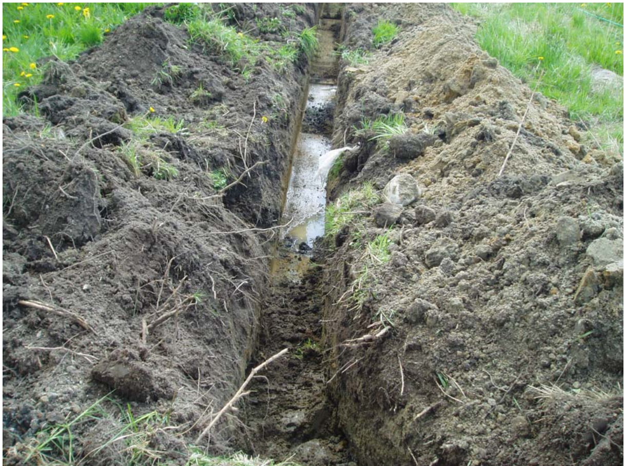
Bild 67. Schakt från 4:7 mot 5:8
