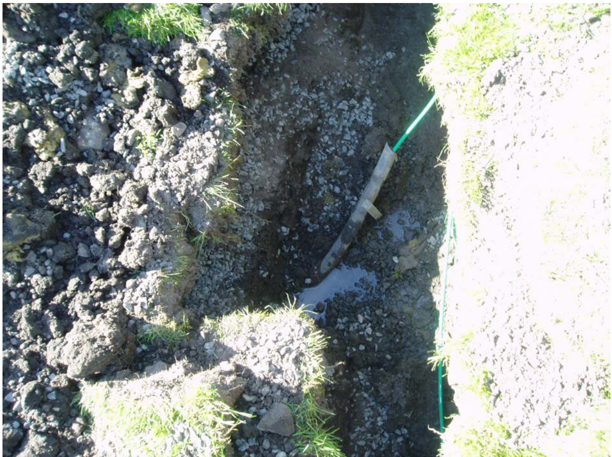
Bild 76. Schakt mot 4:7 b. Tub förläggs i äldre vattenrör.
