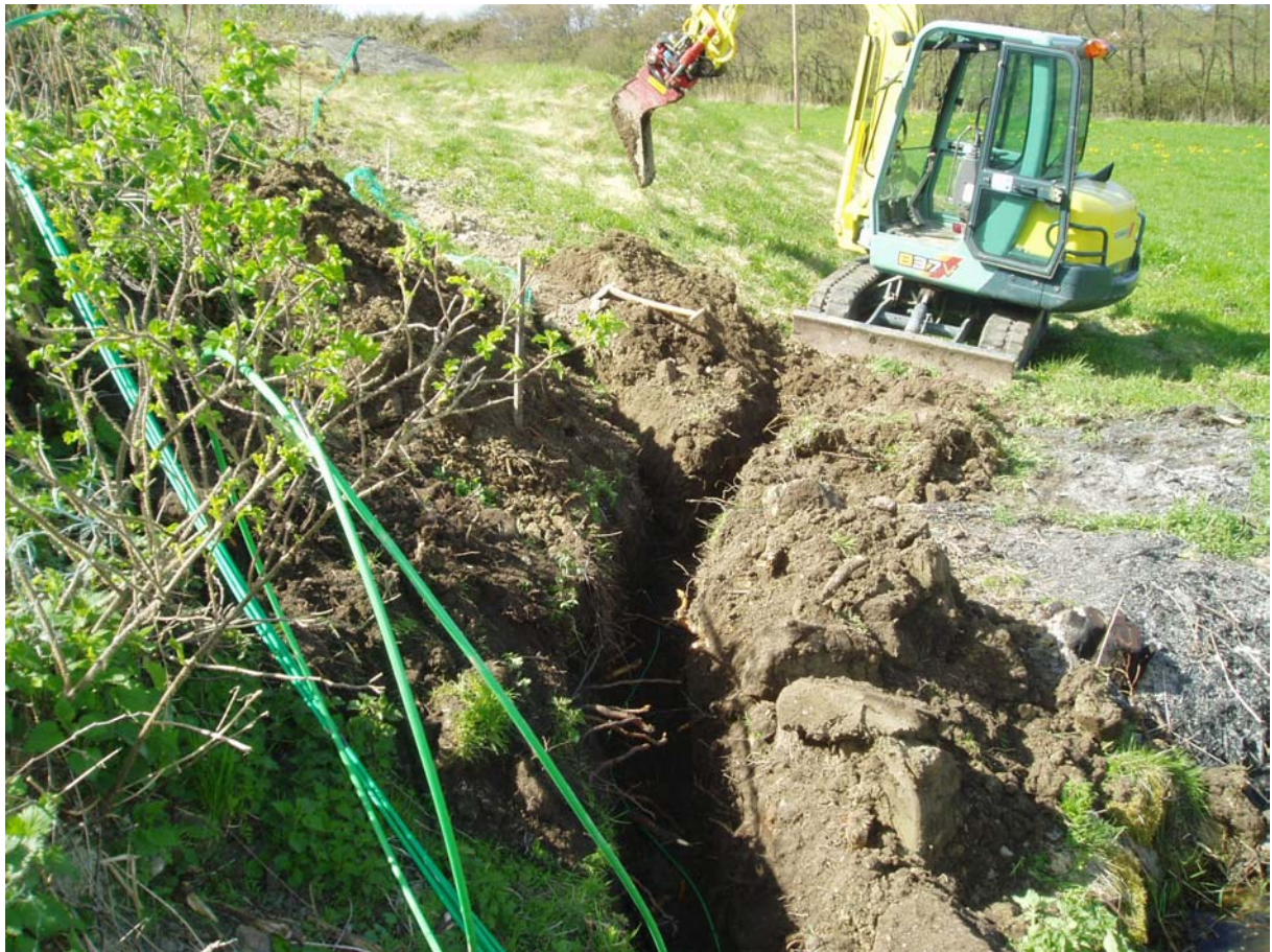
Bild 60. Från skarv 1 tub till 4 tub utanför 4:6 mot fastighet 4:6 och bort mot 4:7
