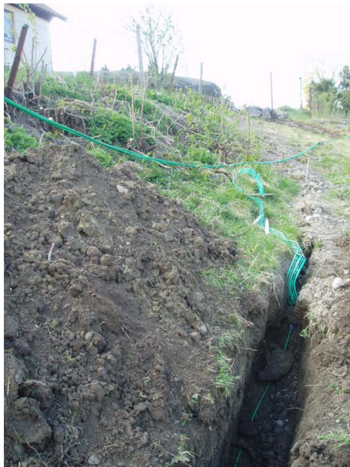
Bild 59. Från skarv 1 tub till 4 tub utanför 4:6 mot fastighet 4:6
