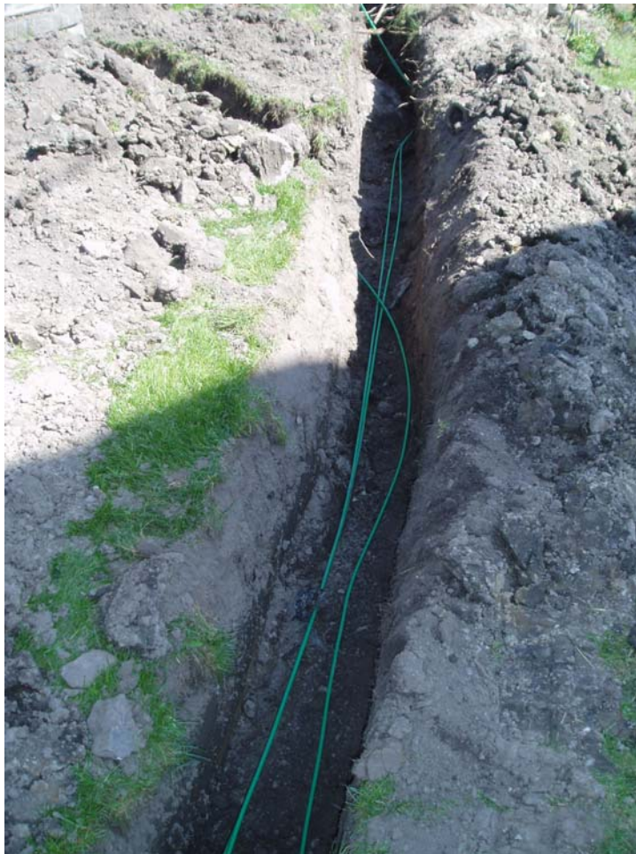
Bild 73. Schakt över 4:7 och mot 5:8
