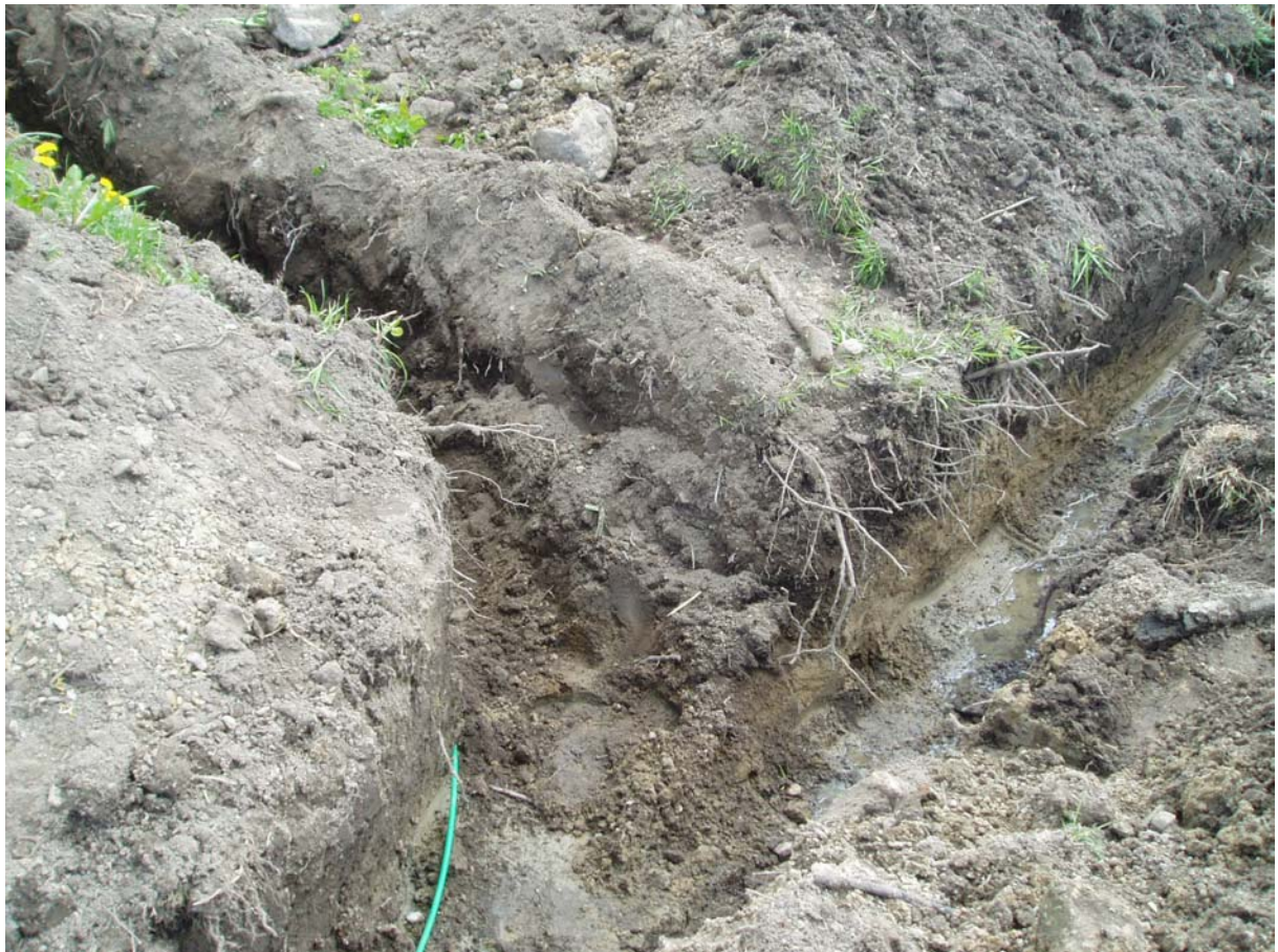
Bild 63. Schakt upp mot 5:8
